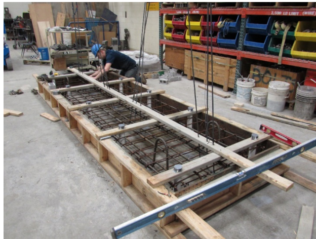
Figure 3-1: Foundation prior to pour
